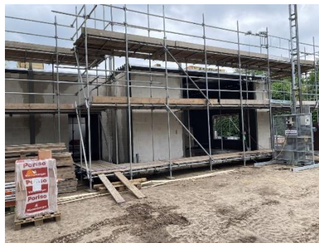
Aanbouw nieuwe kleuterlokalen
