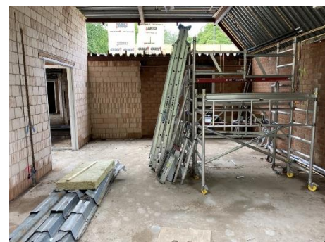
Handvaardigheidsruimte met aansluitend de leskeuken.
